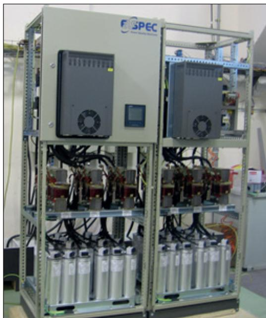
**Figura 22:** Compensador de energia reativa com manobra estática e reatores antirressonantes
